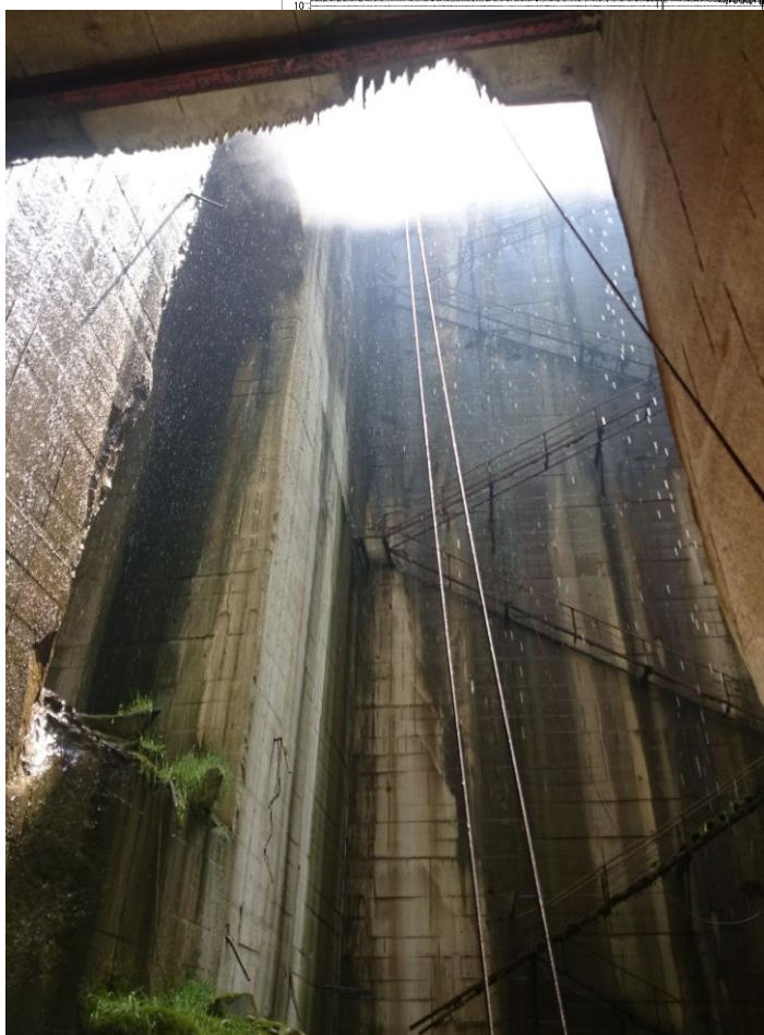
大谷石採取場立坑内(深さ約 60m)
